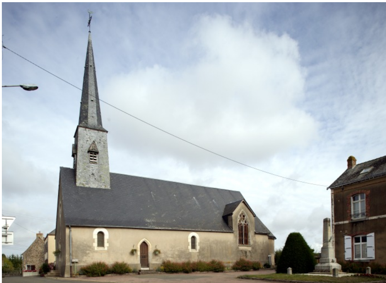
L'élévation sud vue depuis la place.
