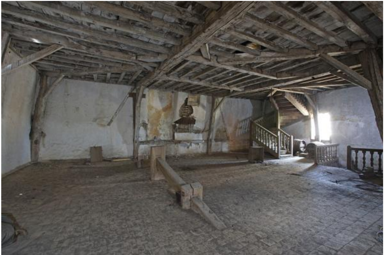
Le corps de commons dit "grange d'abondance", premier niveau de comble et escalier.
