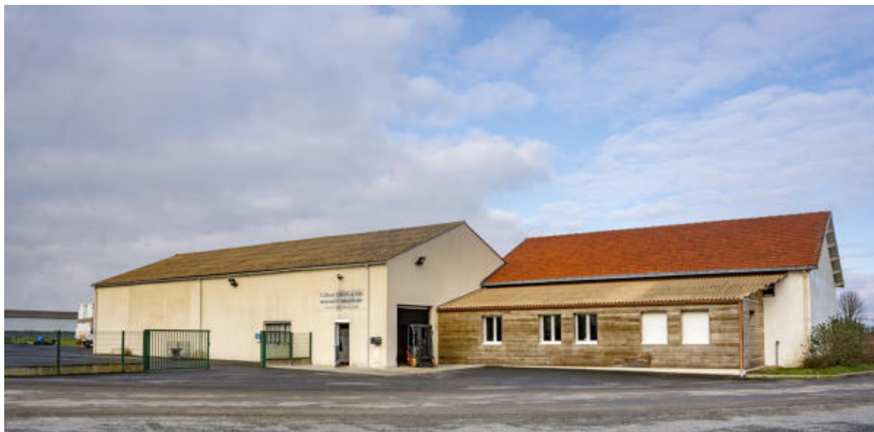
Vue générale, depuis la rue des Alouettes.
