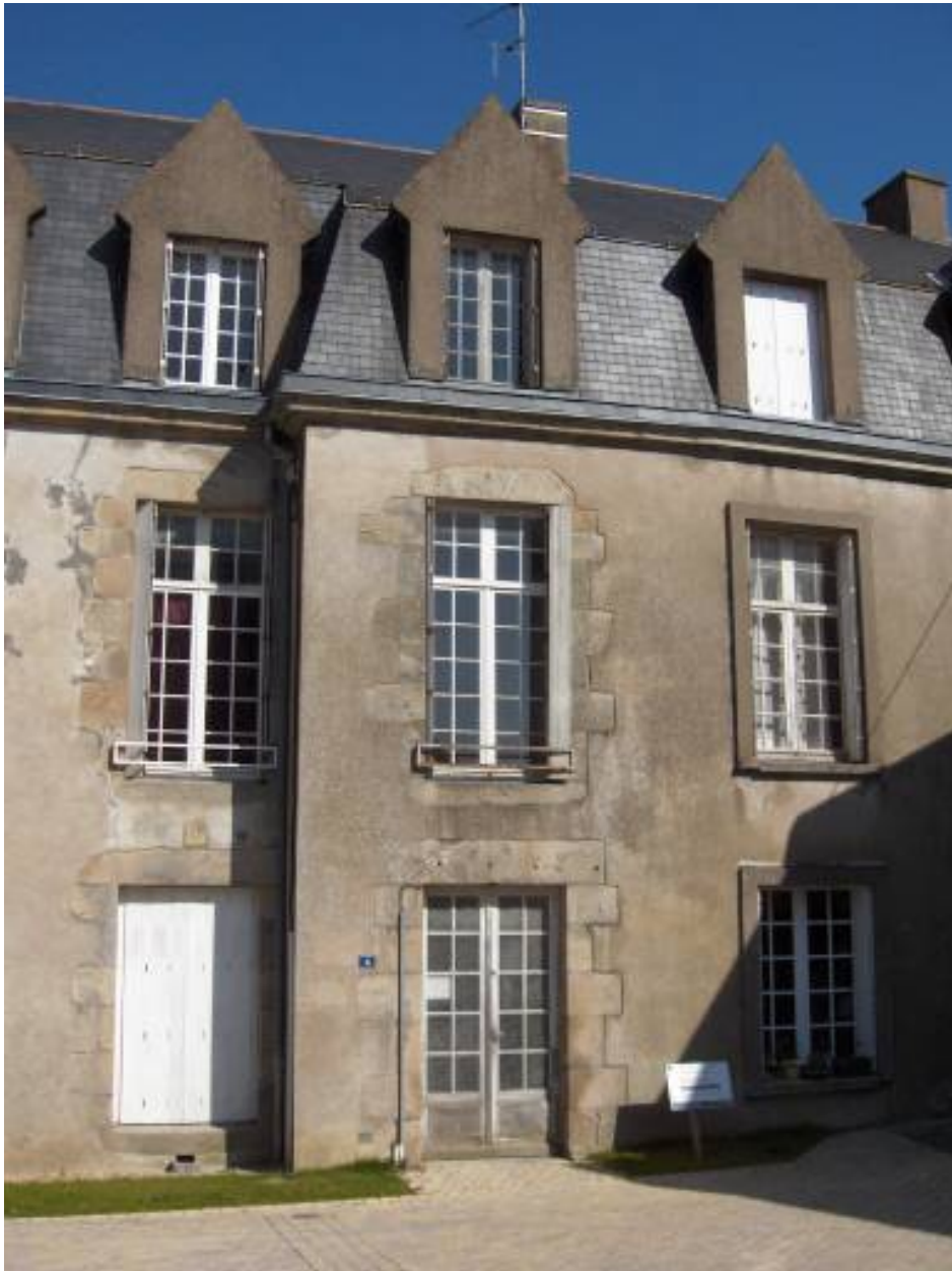
Détail de la façade sud.
