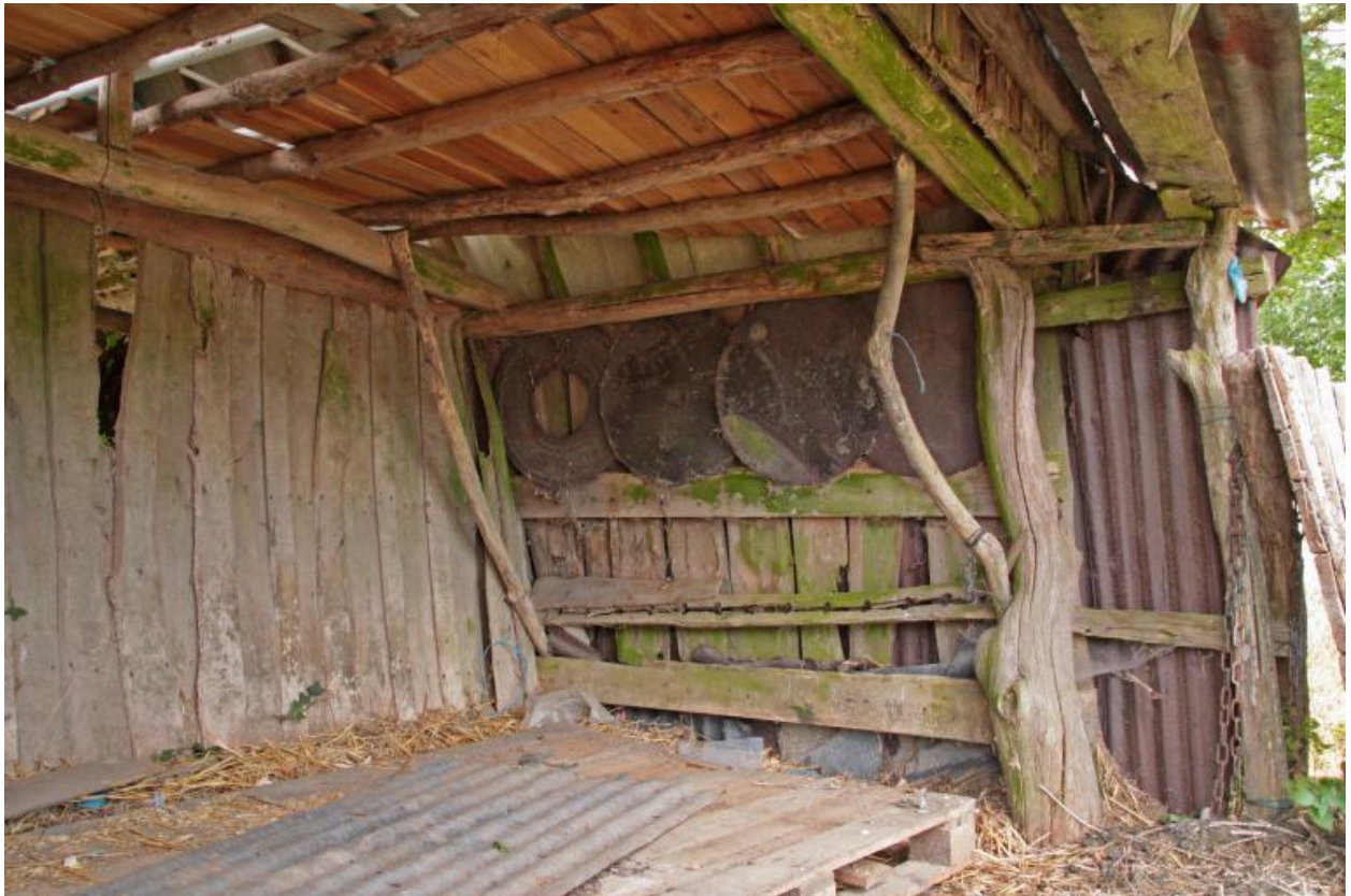
Les abris : vue intérieure.
