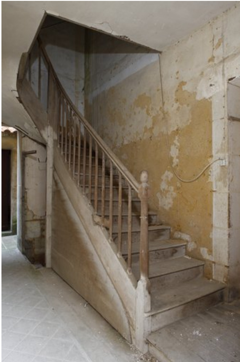
Escalier des communs.
