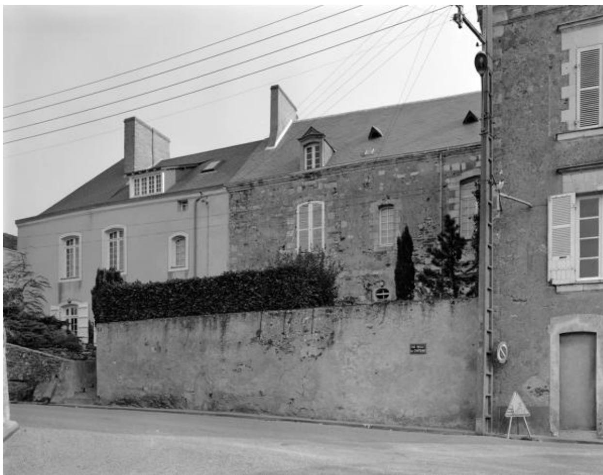
Vue d'ensemble, façades antérieures sur rue.
