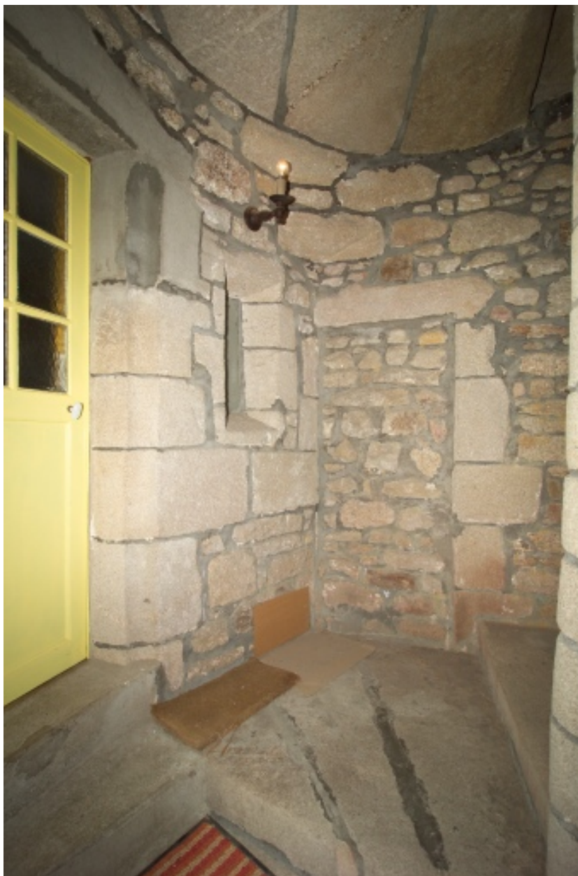
Cage d'escalier, palier du premier étage.
