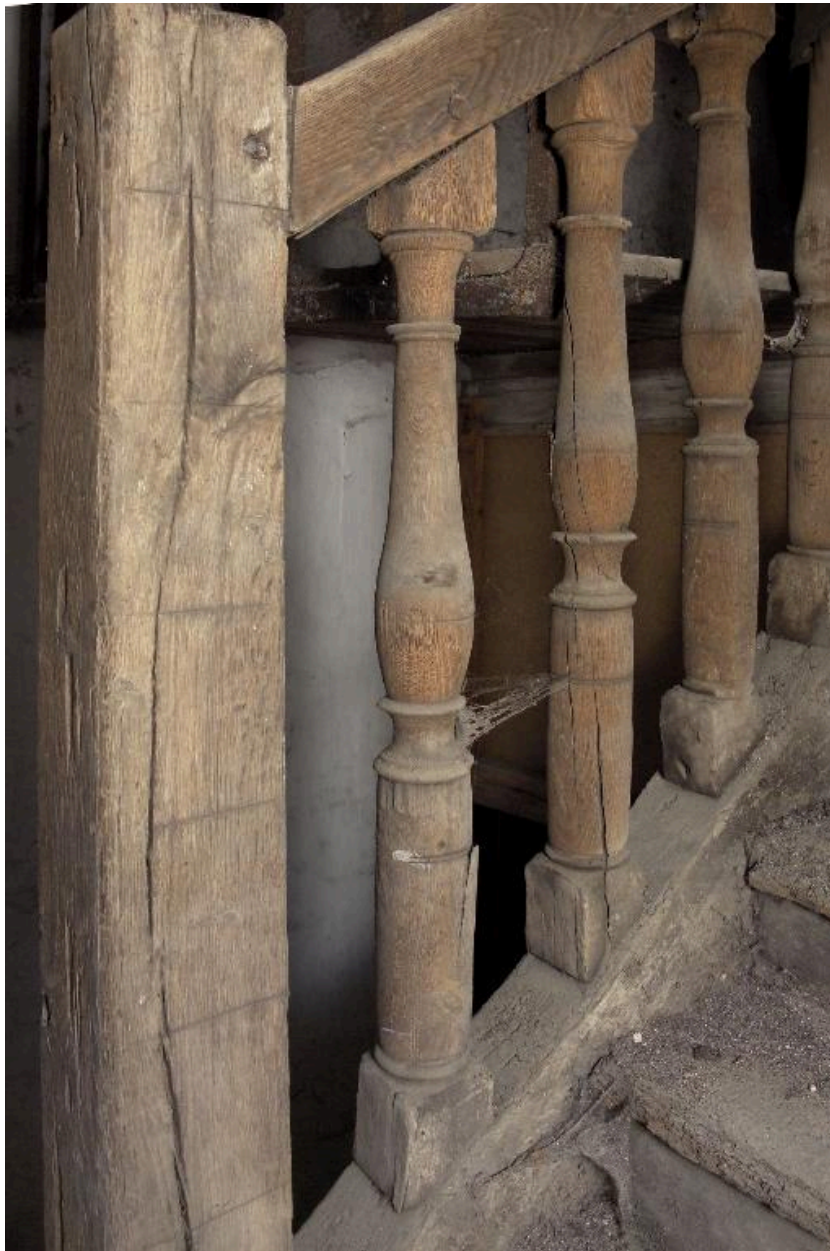
L'escalier, détail des balustres de la dernière volée.
