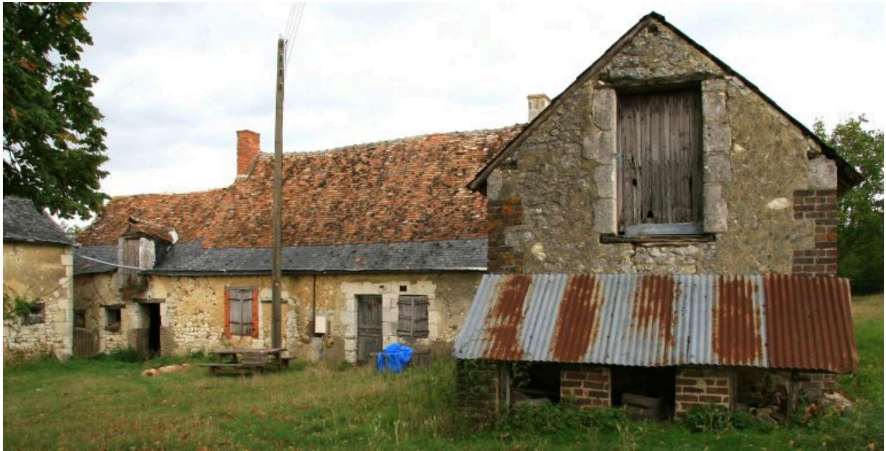
La maison et les toits à porcs.
