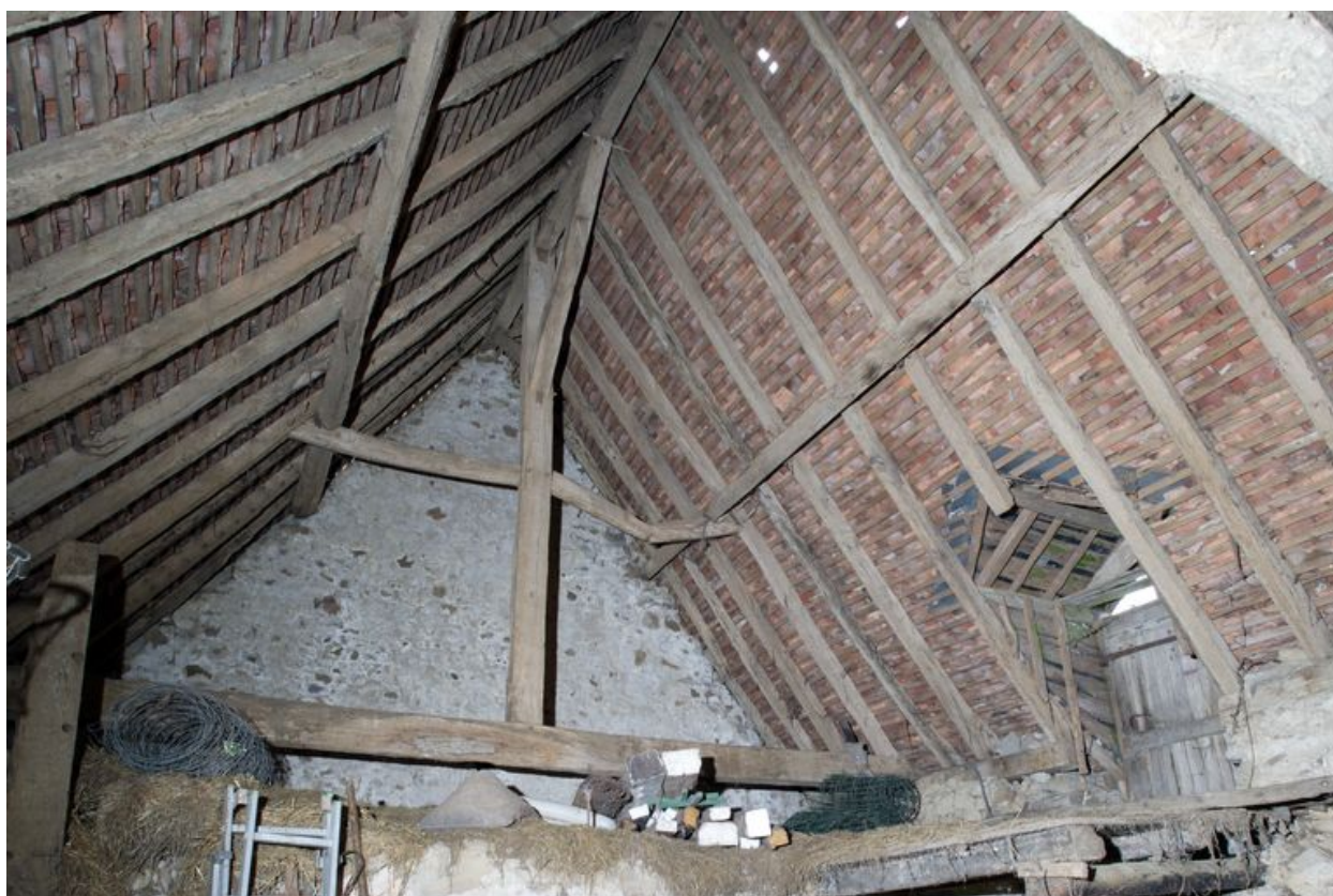
La charpente du logis indépendant sud.
