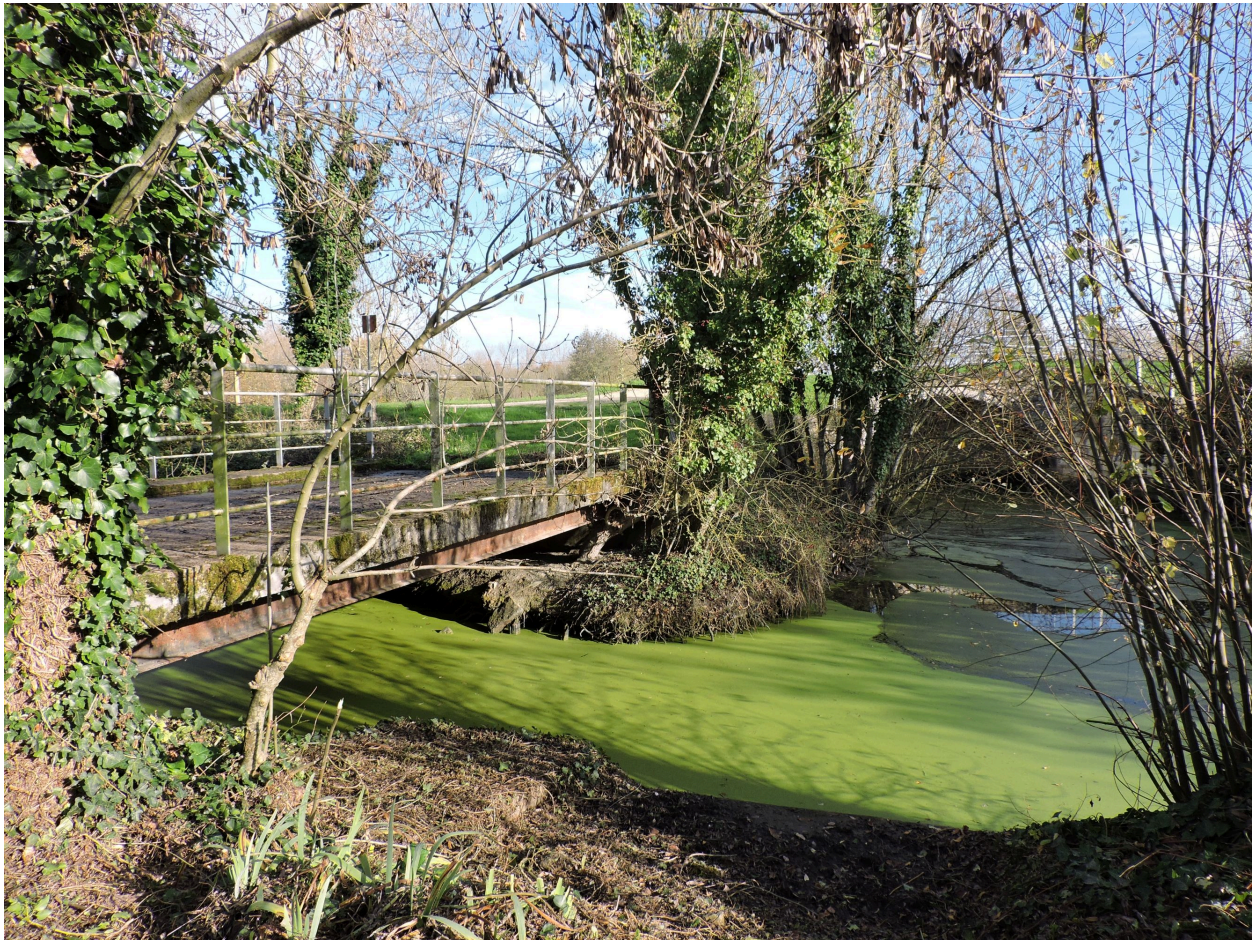
La passerelle reliant la ferme et l'aqueduc, vue depuis le sud-ouest.
