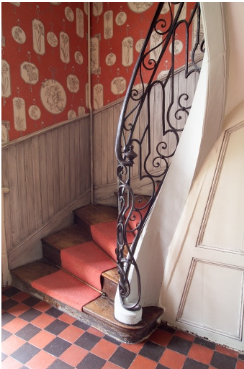
Vue de l'escalier tournant en bois avec rampe en fer forgé.
