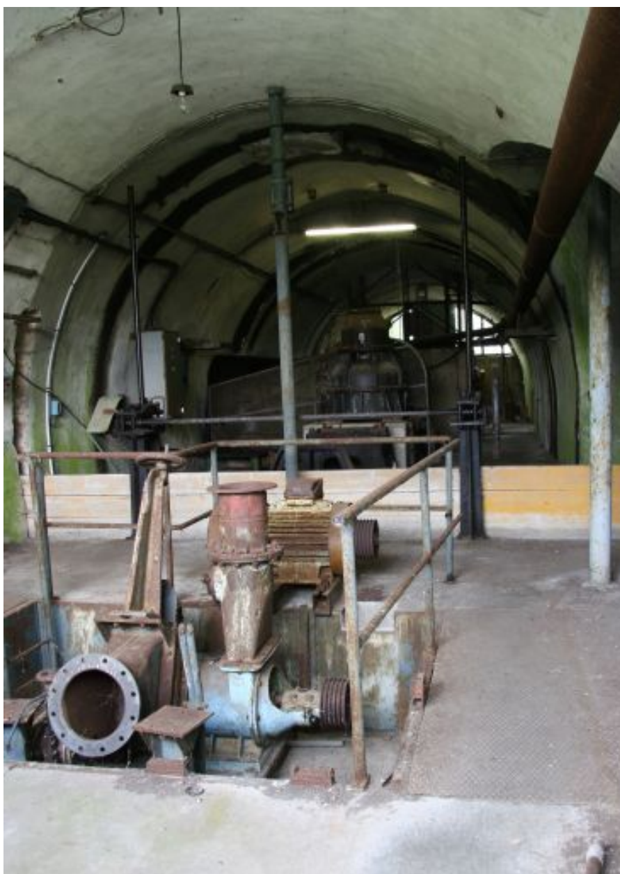
Vue d'ensemble du 4e vaisseau transversal.
