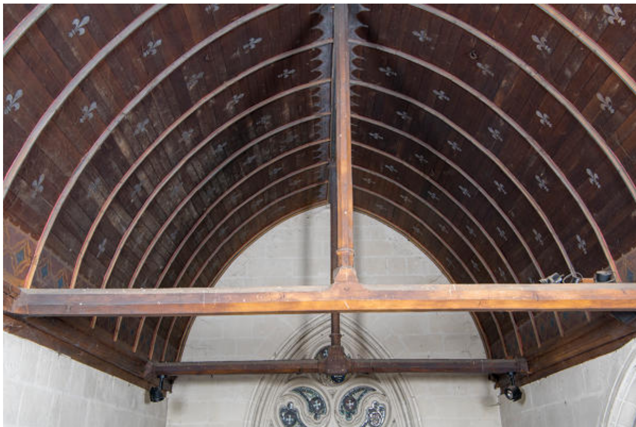
Choeur. Détail de la charpente lambrisée.
