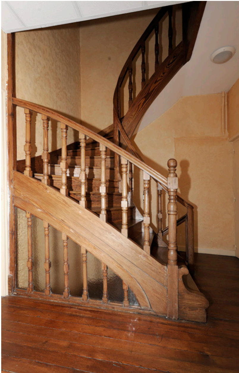
Escalier de distribution et palier du premier étage.
