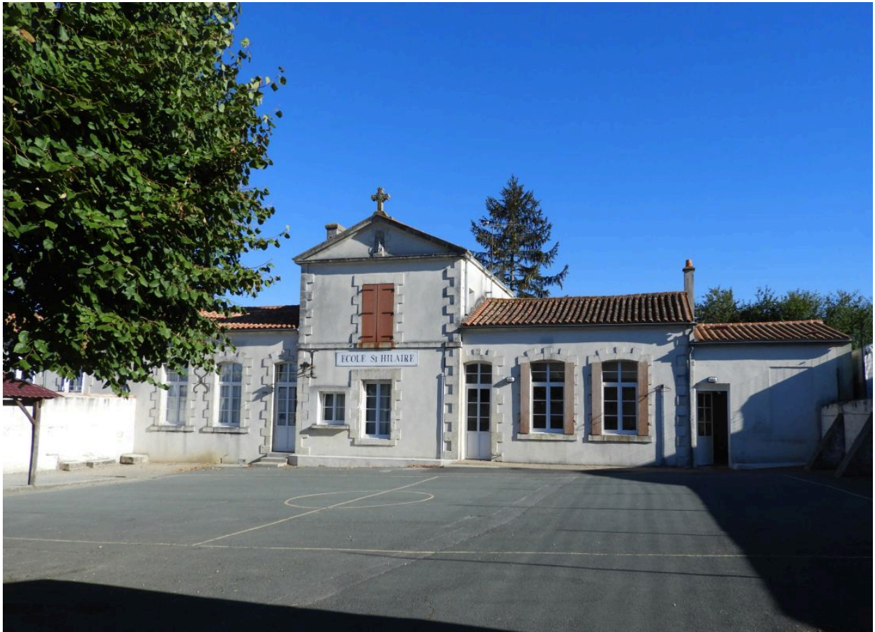
L'école, cour sud-est, vue depuis le sud-est.
