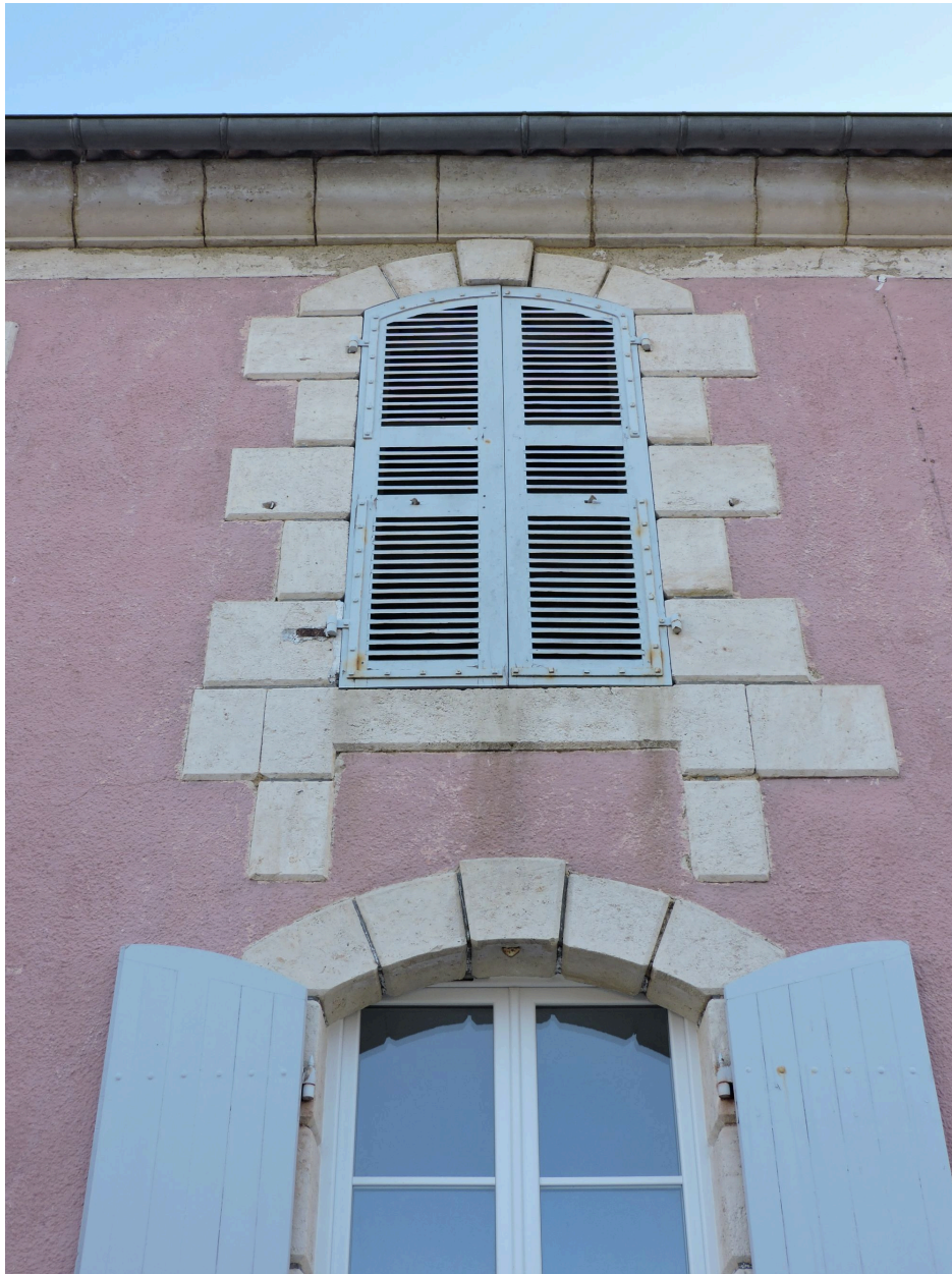
Corniche et encadrements saillants, fin du 19e siècle-début du 20e, Grand rue.
