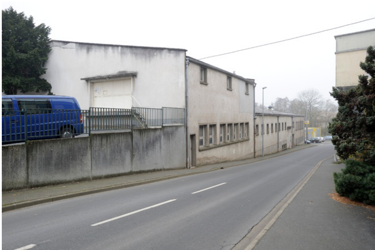
Usine Mogeco (U3), rue Aigrefou.
