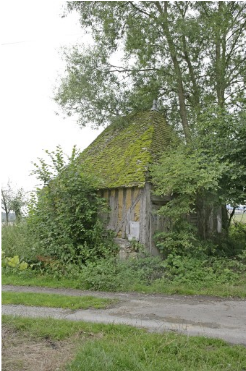
Édifice 1, fournil : vue des élévations en pans de bois depuis le chemin.
