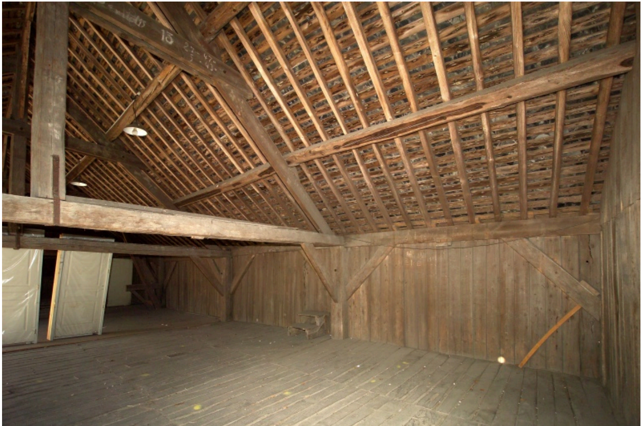
Cour d'entrée, détail de charpente d'un hangar.
