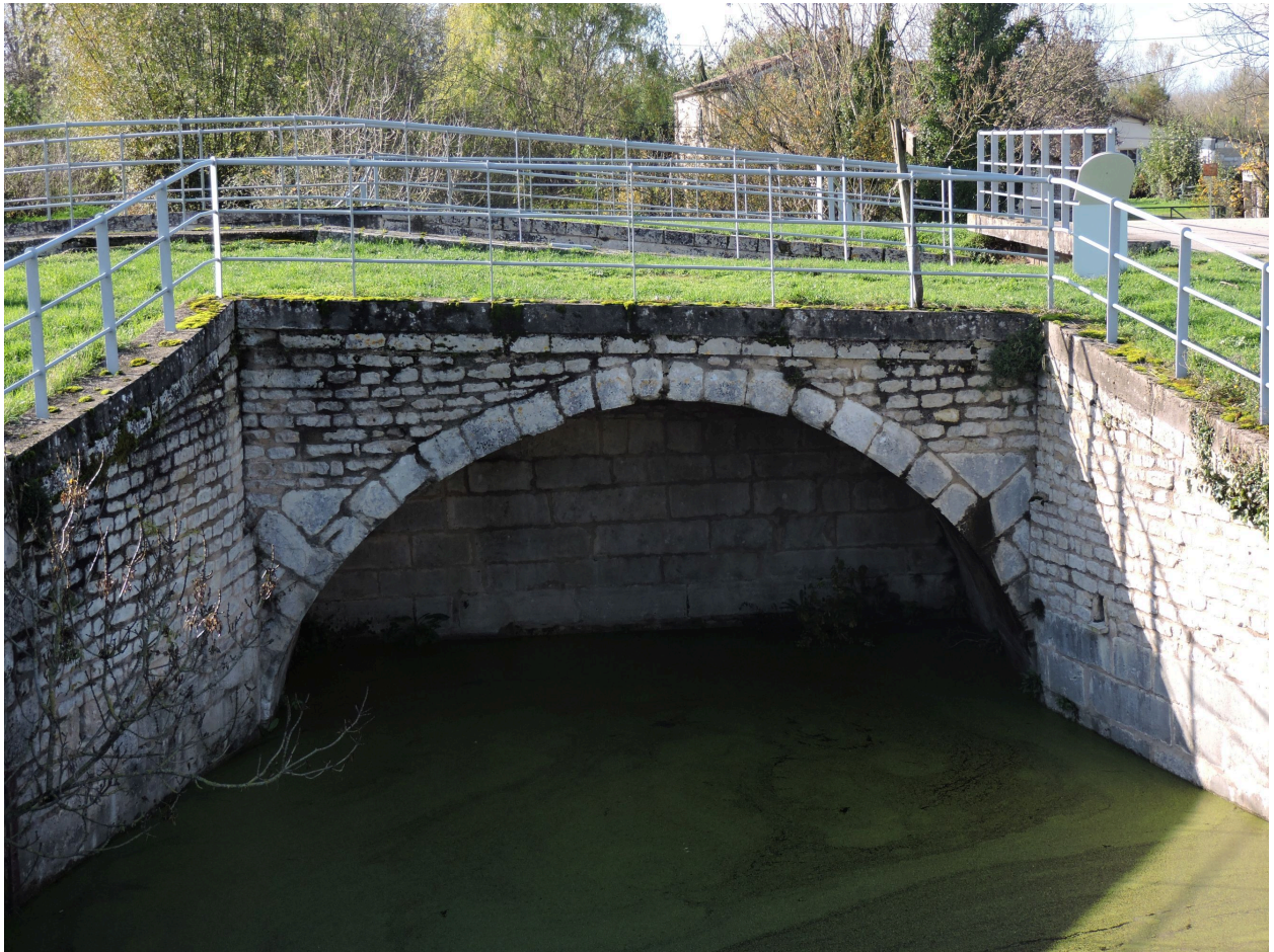
Le pont encadrant l'ancien aqueduc, arche orientale, vu depuis l'est.
