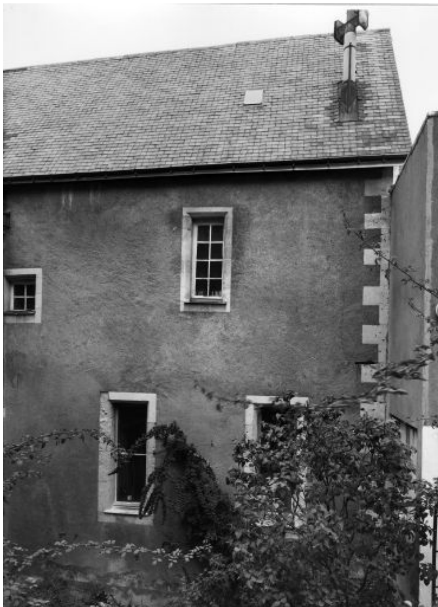
Aile postérieure gauche : façade antérieure sud, sur la cour arrière.
