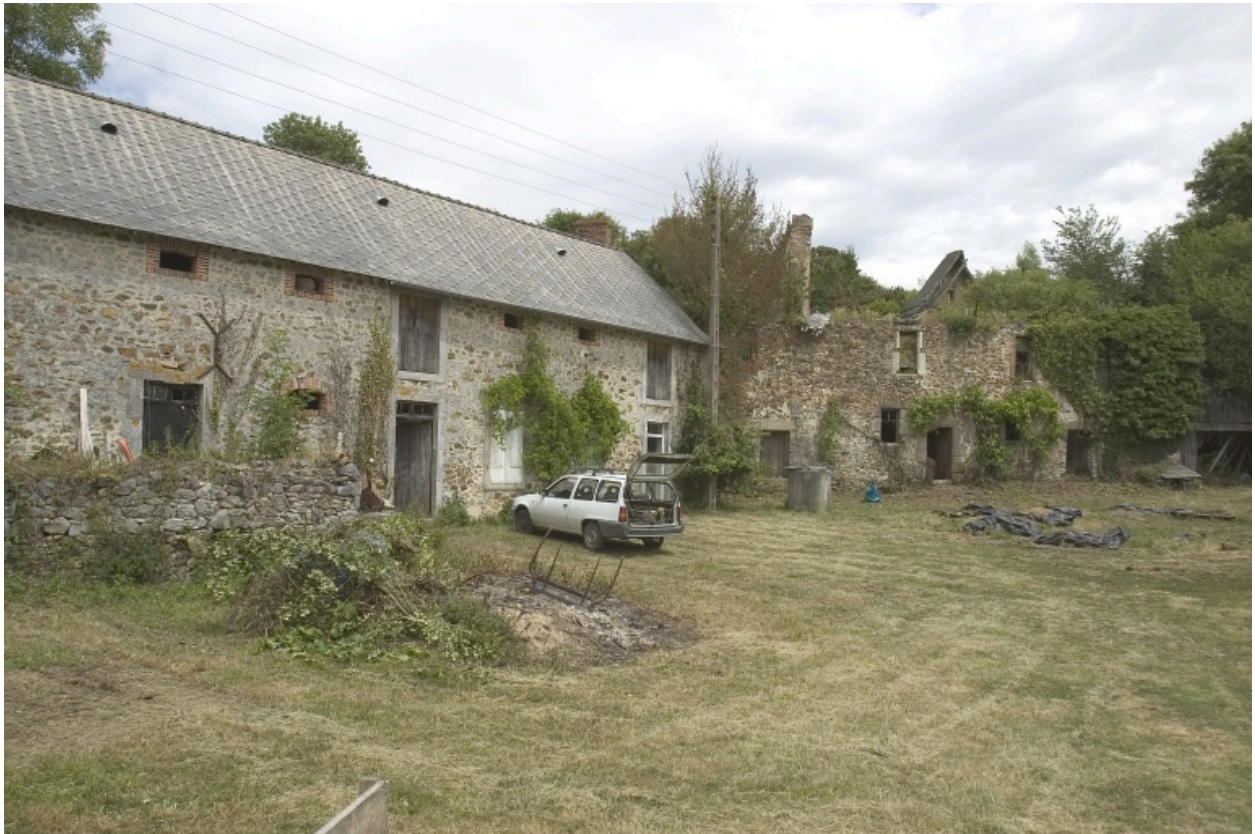
Le logis-étable-grange et le logis vus depuis le sud-ouest.
