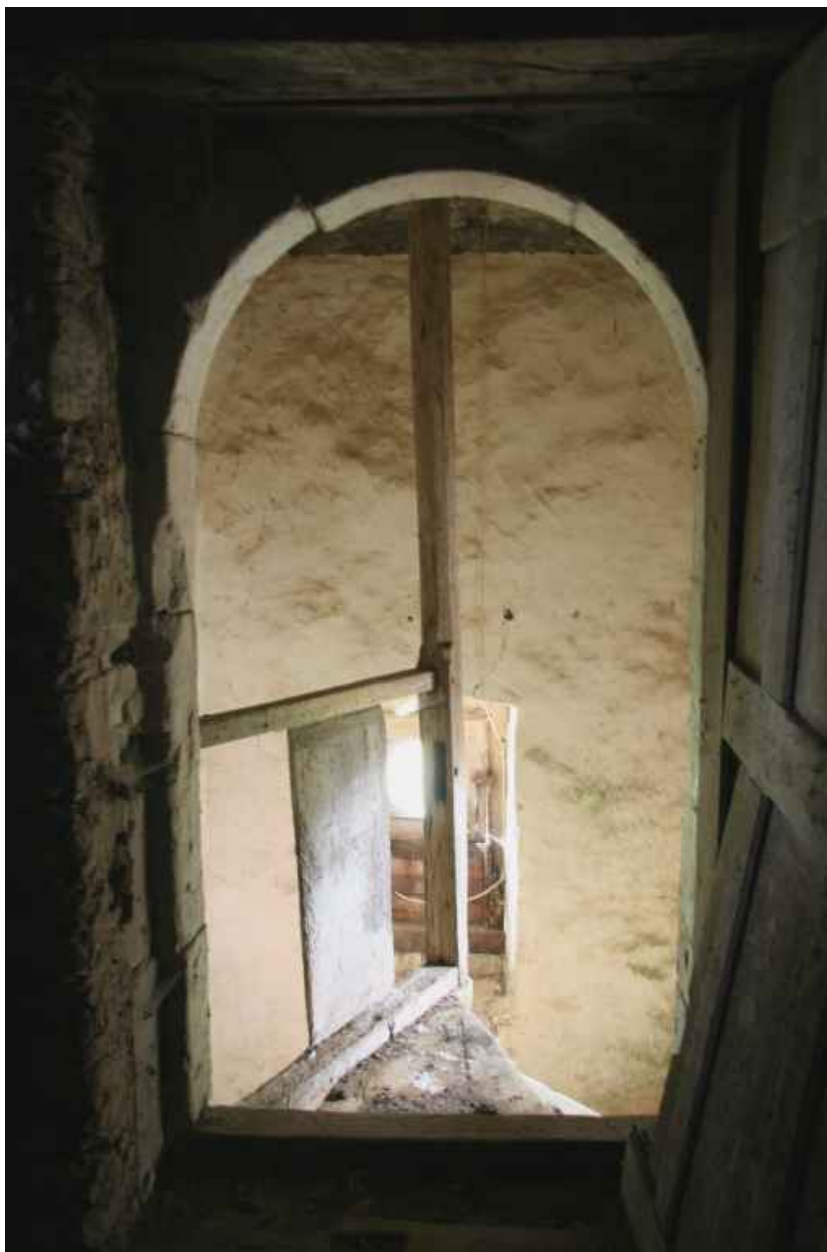
Tourelle d'escalier : dernier palier avec le poteau en bois relié à la charpente.
