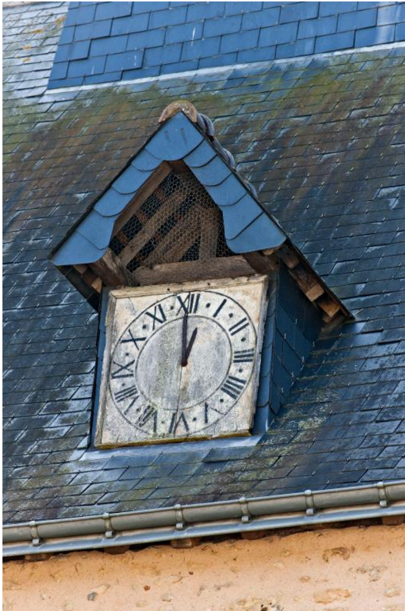
Horloge sur la toiture, au-dessus du côté nord de la nef.
