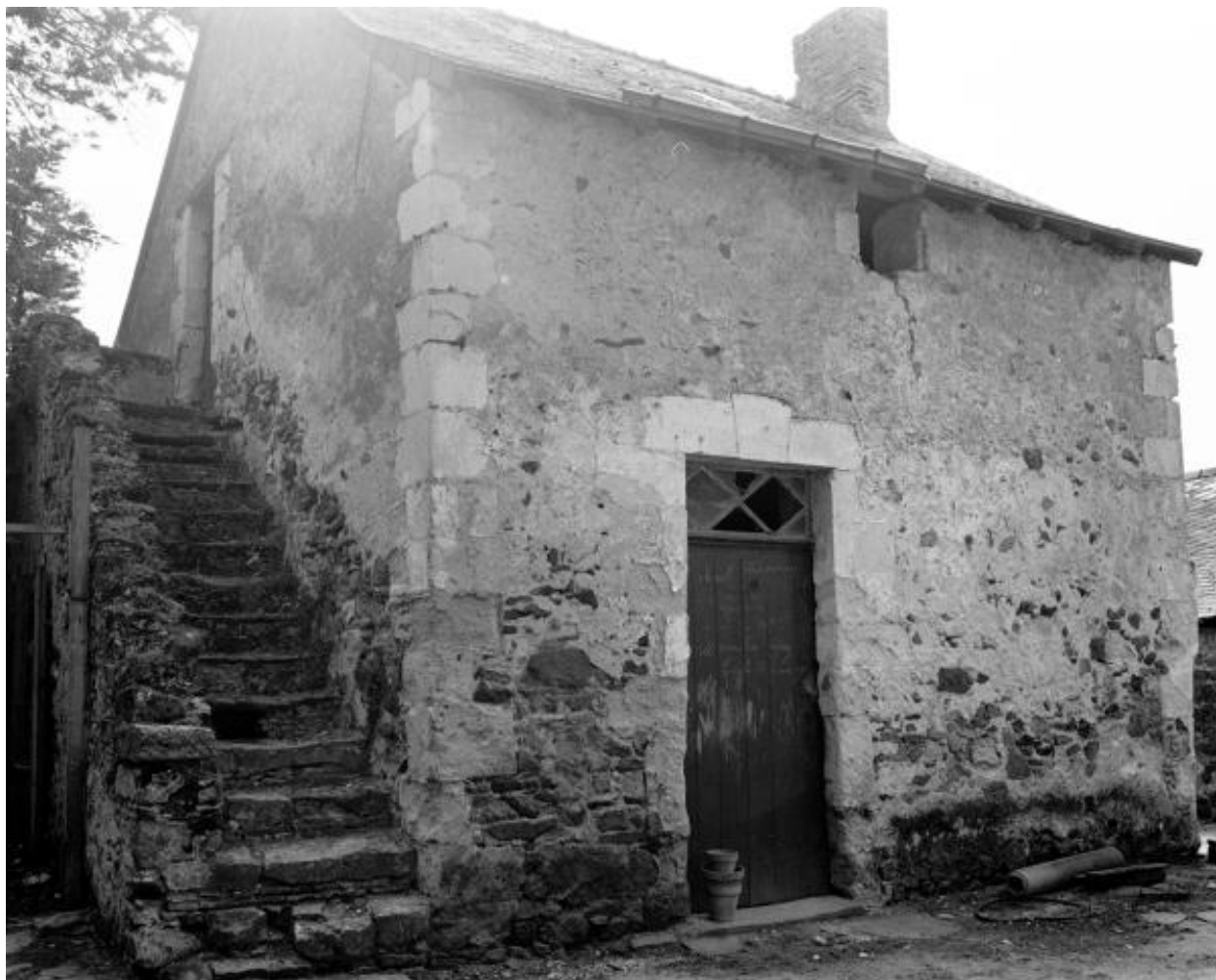
Façade antérieure du logement sur cour.
