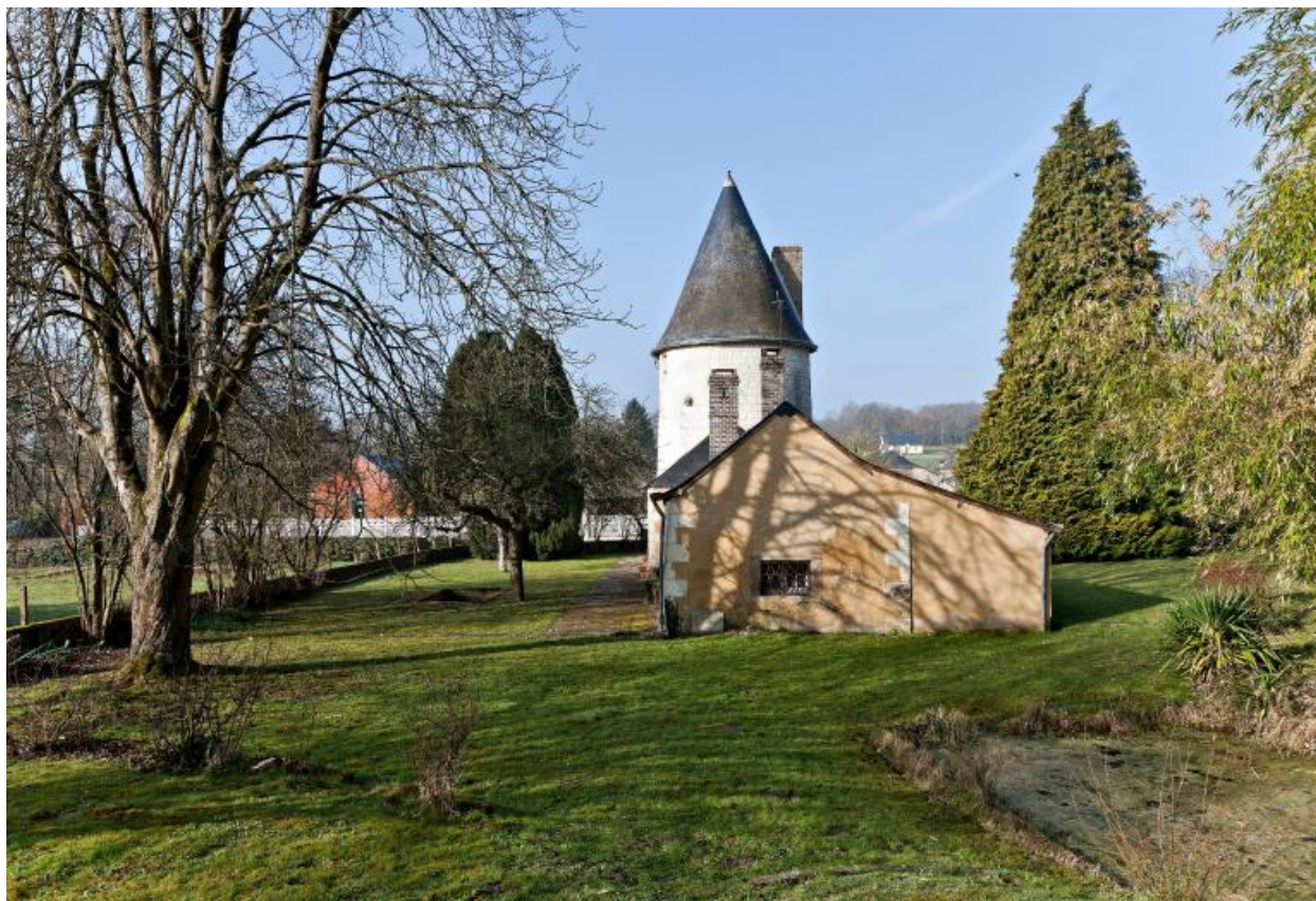
Vue prise depuis l'est. Habitation accolée à la tour au XIXe s. (?).
