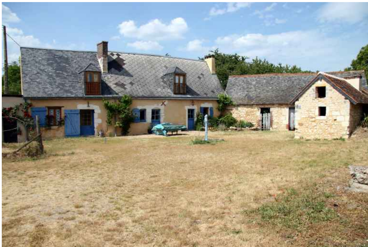
Vue d'ensemble de l'habitation et des communs.
