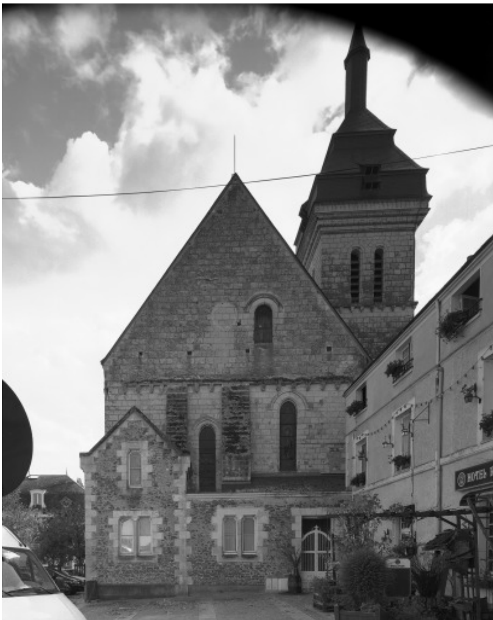
Pignon nord du chœur.
