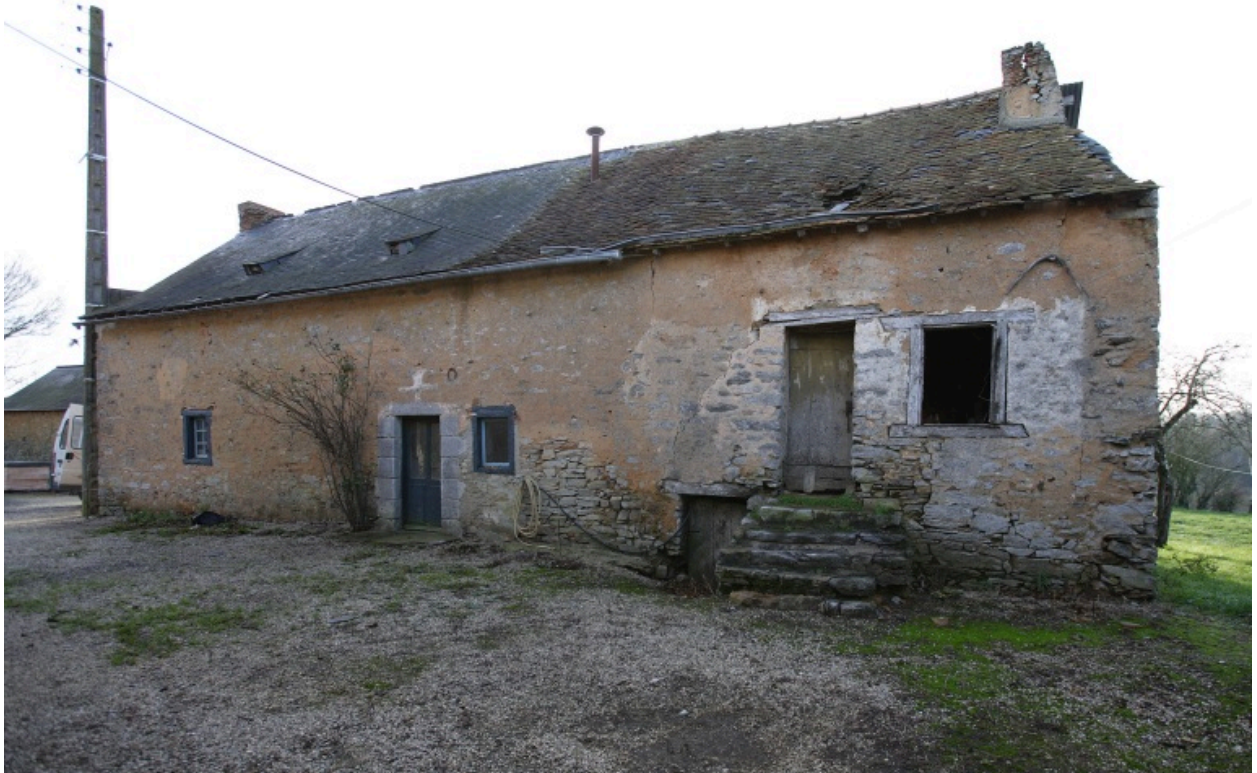
Le logis vu depuis le nord-est.
