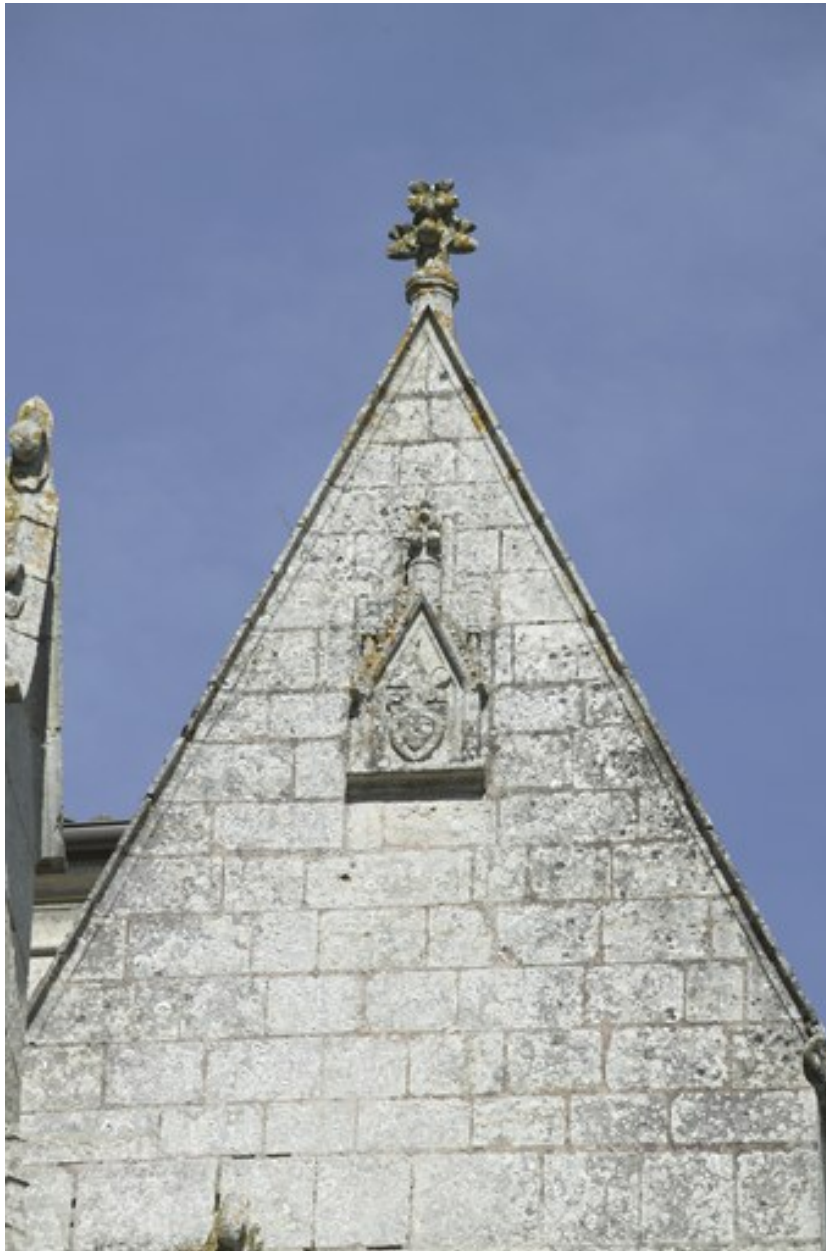
Pignon du contrefort du bras sud du transept, aux armes d'Elie Martineau (évêque de 1418 à 1424), selon l'abbé de Beauregard.
