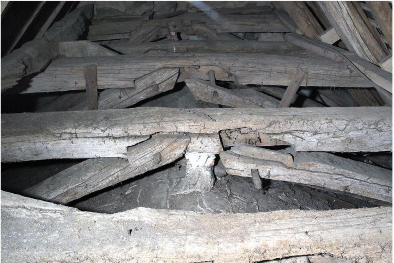
Charpente du chœur, 8e et 9e fermes, côté ouest : détail d'assemblage entre le faux entrait et les arbalétriers.
