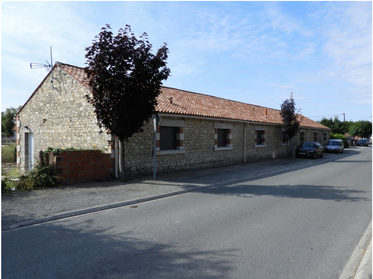
L'ancien atelier de vannerie, avenue de la Gare, vu depuis le nord.
