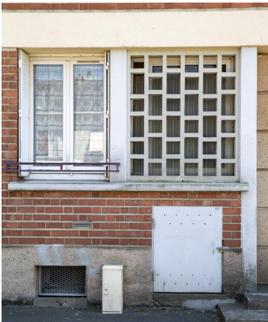
Détail d'une fenêtre et d'une claustra en béton du bâtiment B1.
