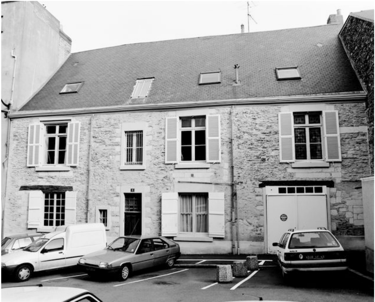
Bâtiment XVe (ancienne infirmerie ?), adressé 76 rue du Mail et 5 cour des Cordeliers : élévation sur la cour des Cordeliers, côté enclos.
