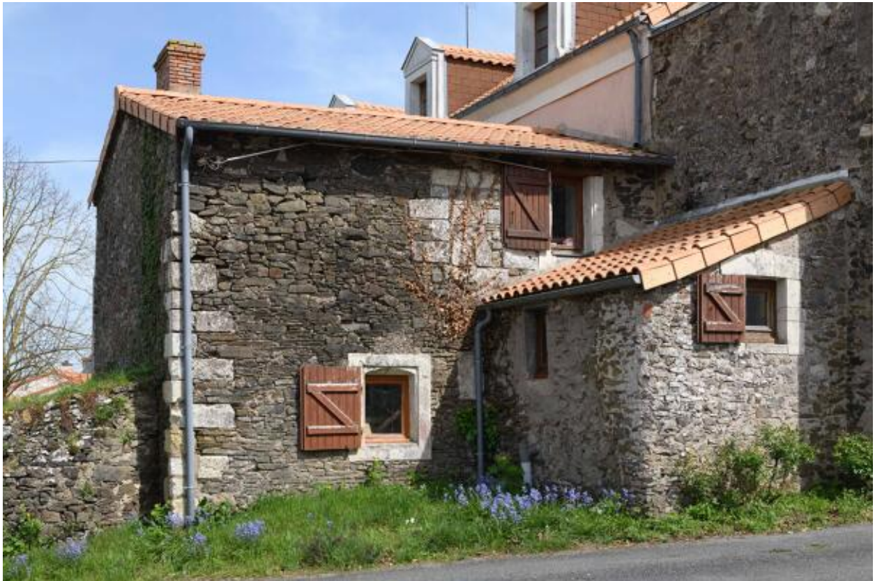
La Peltrie. Vue des bâtiments longeant la rue.
