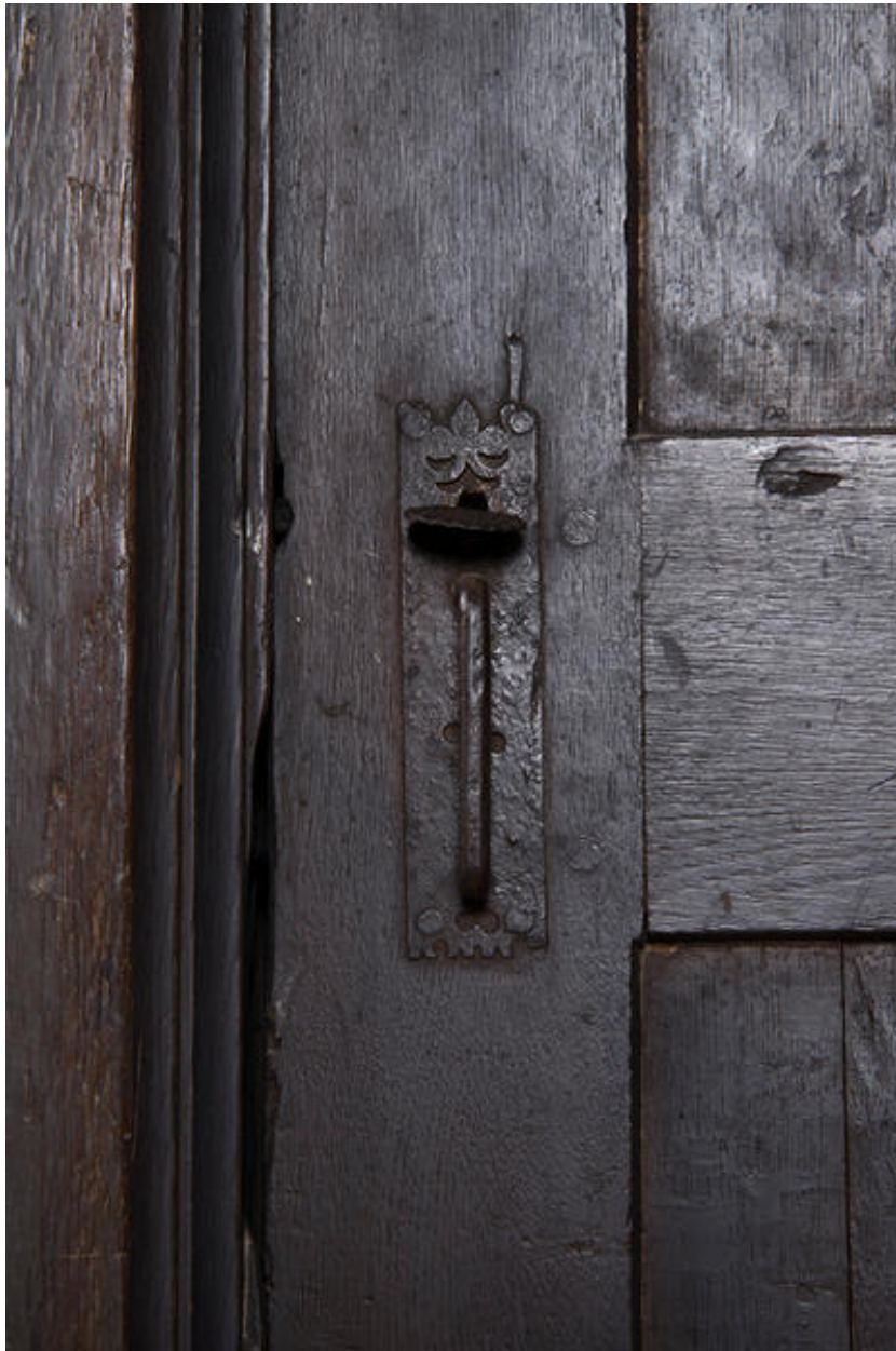
Tribune. Détail de la serrurerie de la porte d'entrée extérieure.
