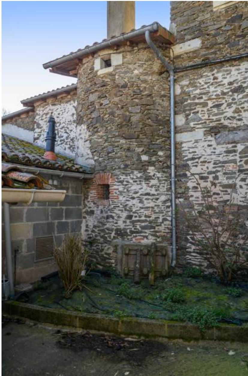
Vue de la tour circulaire adossée au mur nord de l'office.
