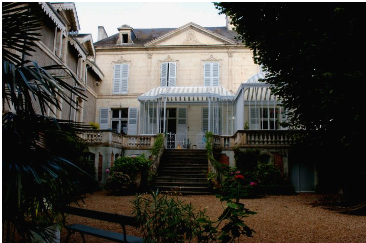
Façade sur la cour et le jardin.
