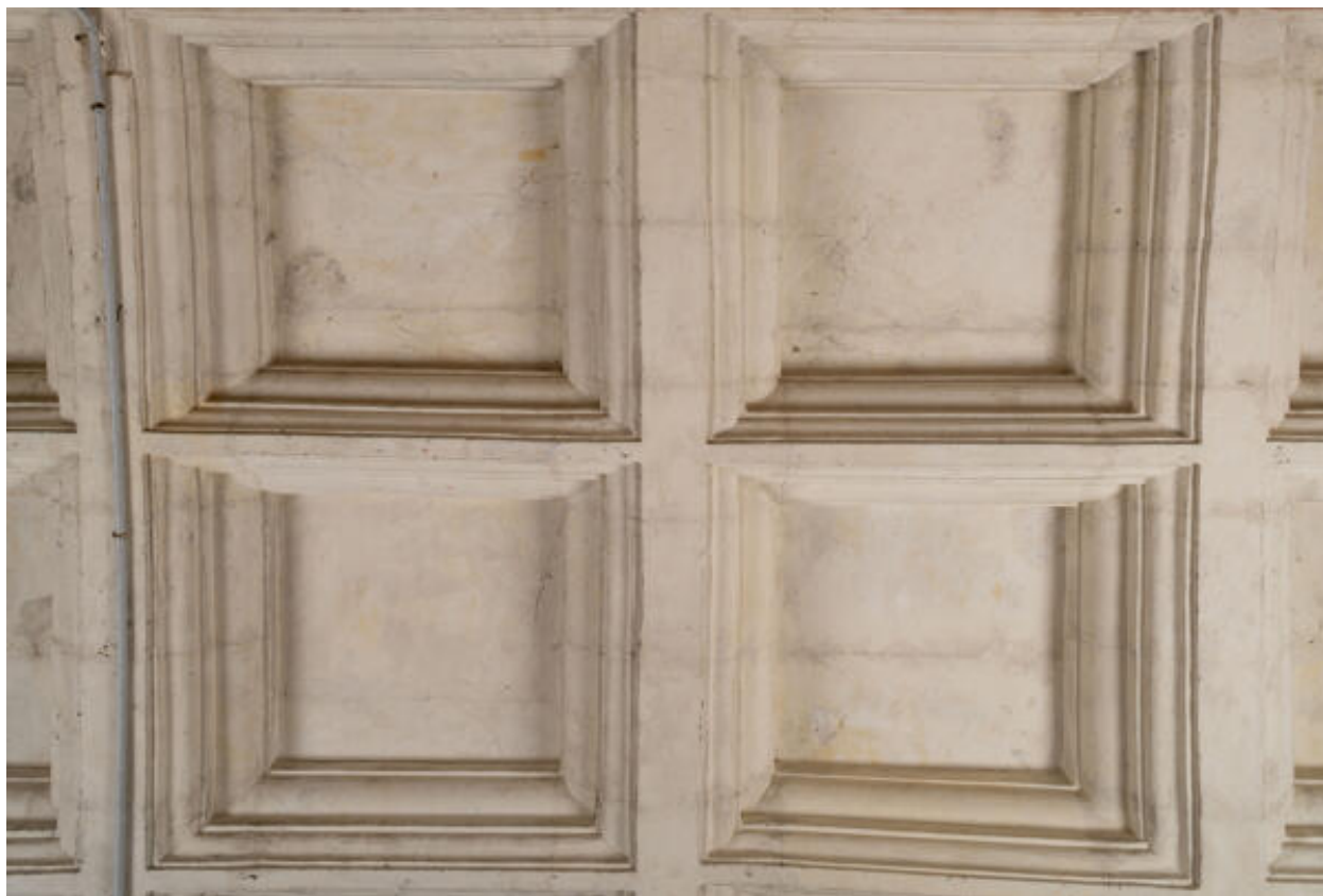
Chapelle basse : détail de la voûte à caissons.
