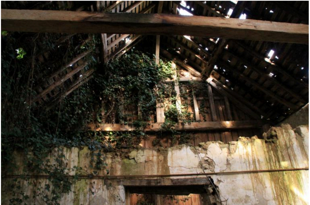
Maison 1, cloison intérieure en maçonnerie, pignon en essentage remanié.
