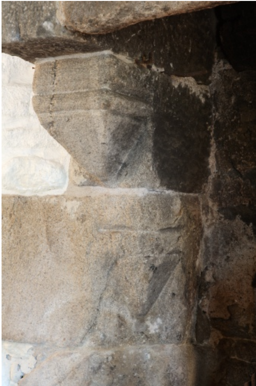
Détail de la console de gauche de la cheminée du rez-de-chaussée du logis est.
