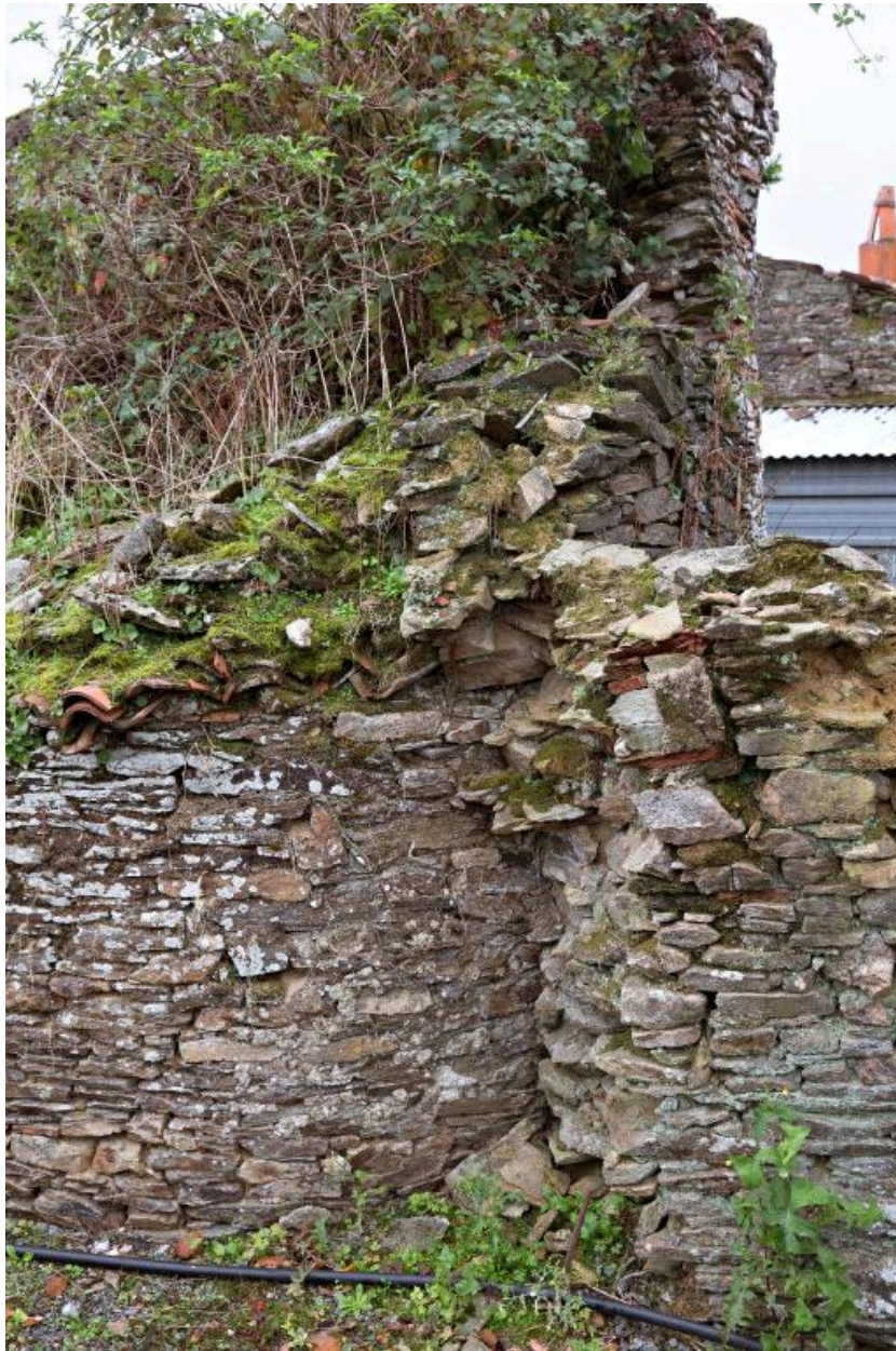
Détail de maçonnerie en pierres de schiste et terre. La Rinière des Landes, Le Loroux-Bottereau.
