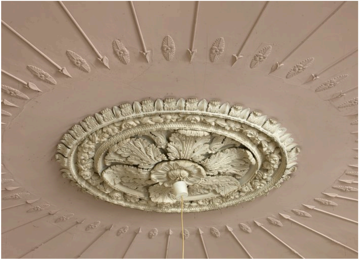
Salon du n° 6 : rosace du plafond et pointes de flèches.
