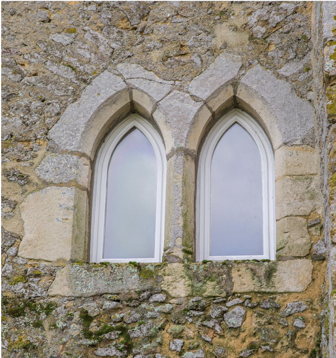
Les baies géminées.
