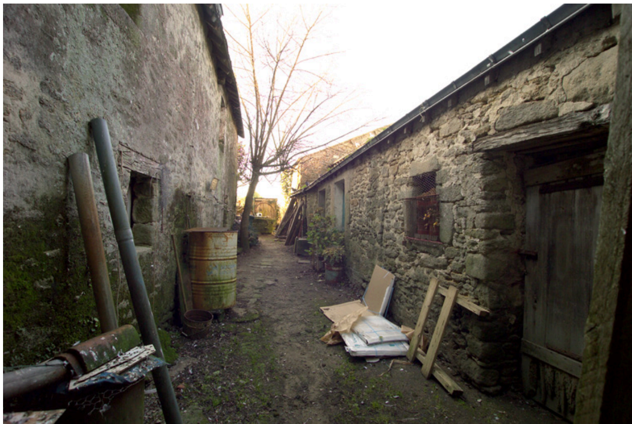
Cour arrière, vue générale vers le sud.
