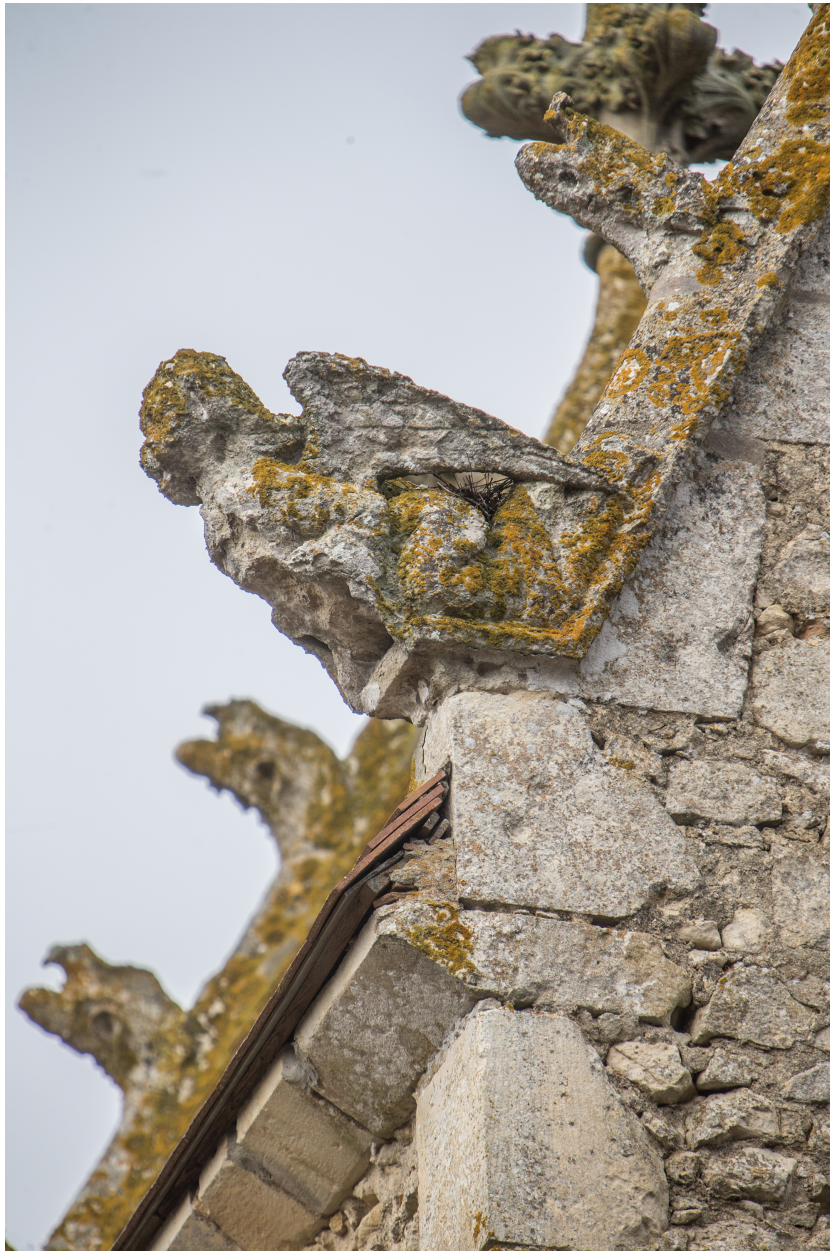
Un détail du sommet du clocher, acrotère, créature ailée.
