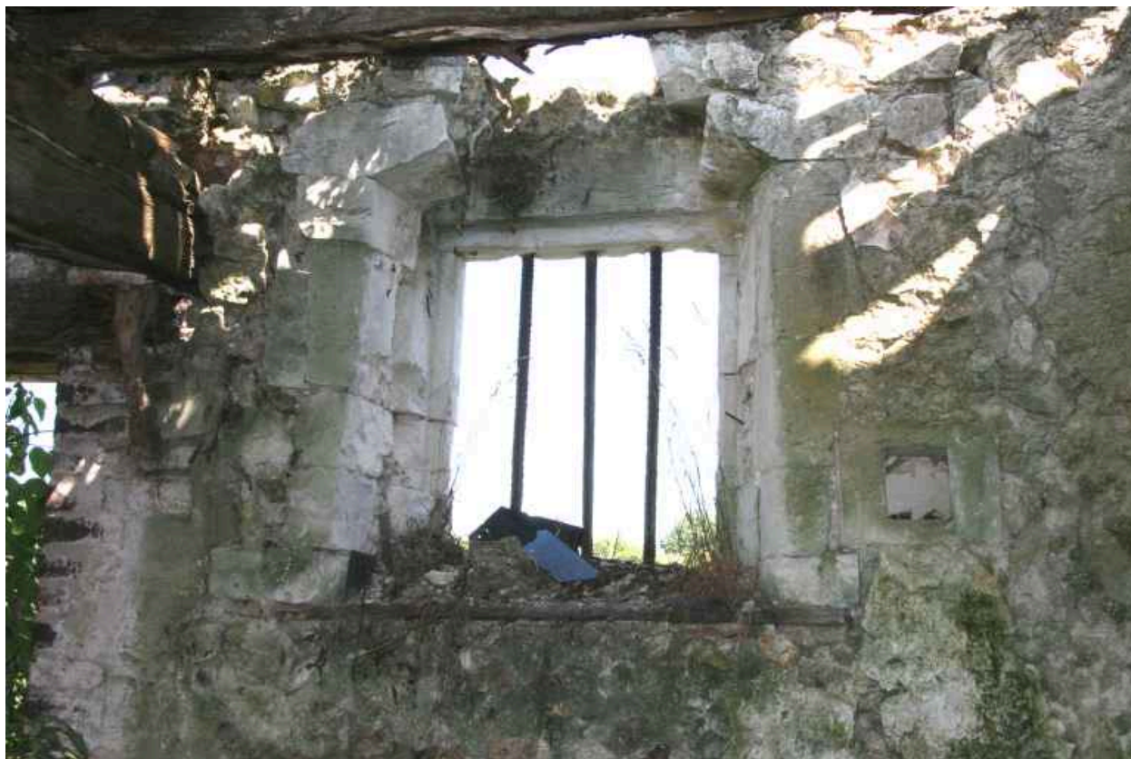
Maison n°2, façade antérieure : fenêtre à barreaux.
