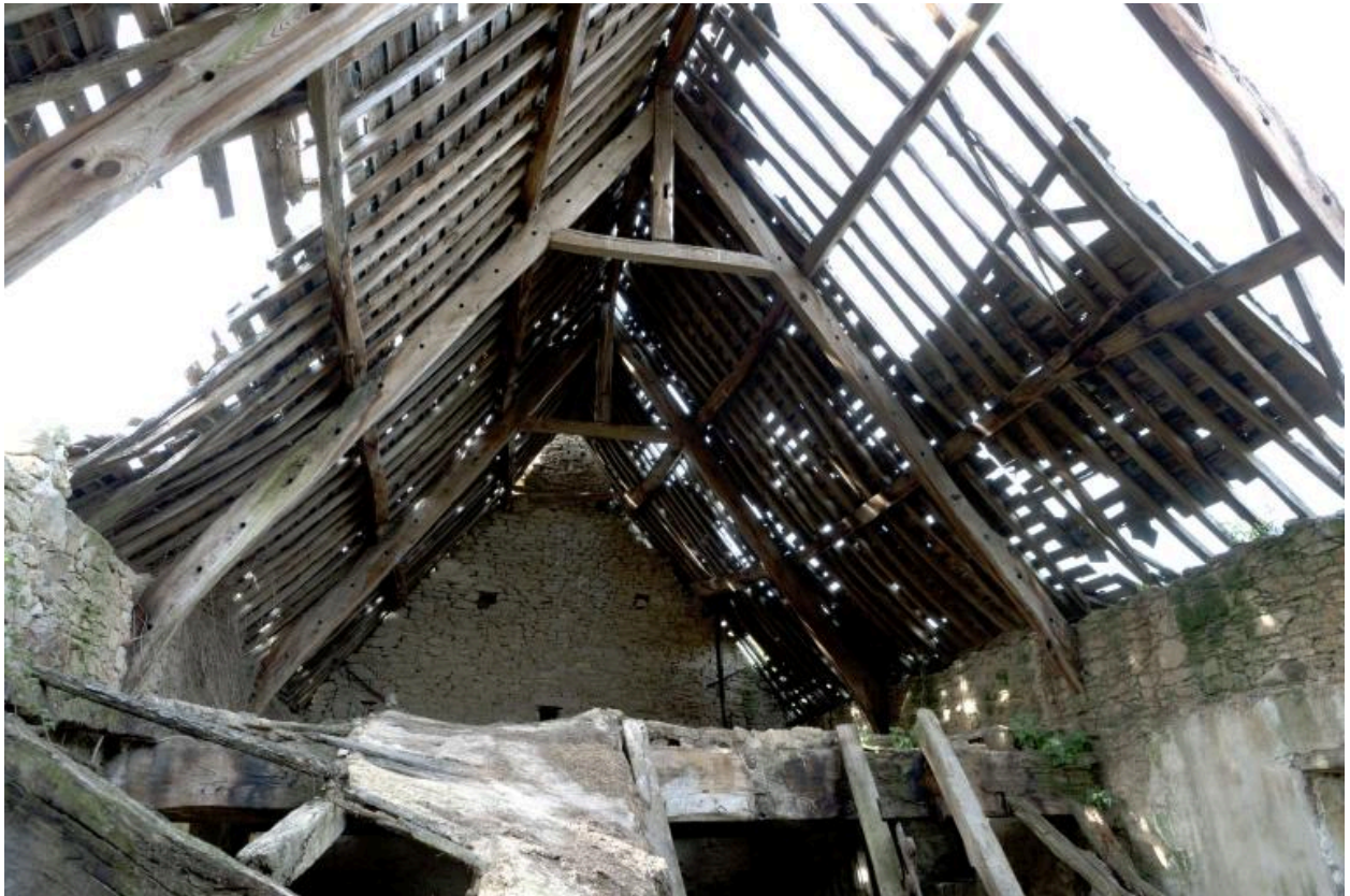
Bogat, vue partielle de la charpente de la métairie.
